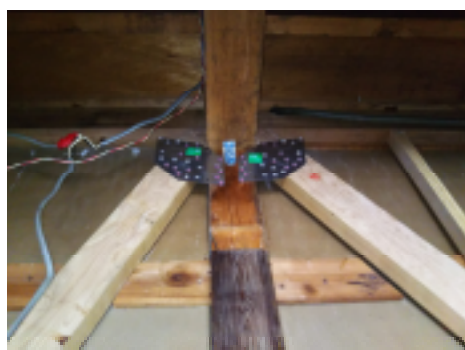
・補強金物で補強
