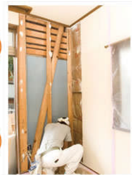
隣の壁もはがす。
