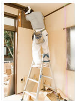
古い壁をはがす。
