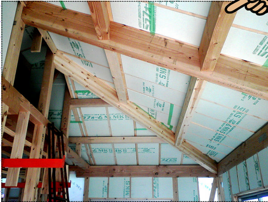
上尾市小泉 T様邸 新築現場
